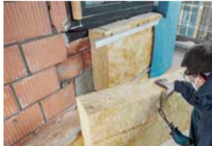
Pencere, kapı ve havalandırma boruları için hassas ayarlama kesimleri
