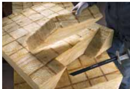
Elyafli yalıtım malzemelerinin bina konstrüksiyonuna uygun hale getirilmesi için hassas kesimler
