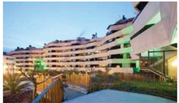
Konut Kompleksi (çatı bahçeleri)
